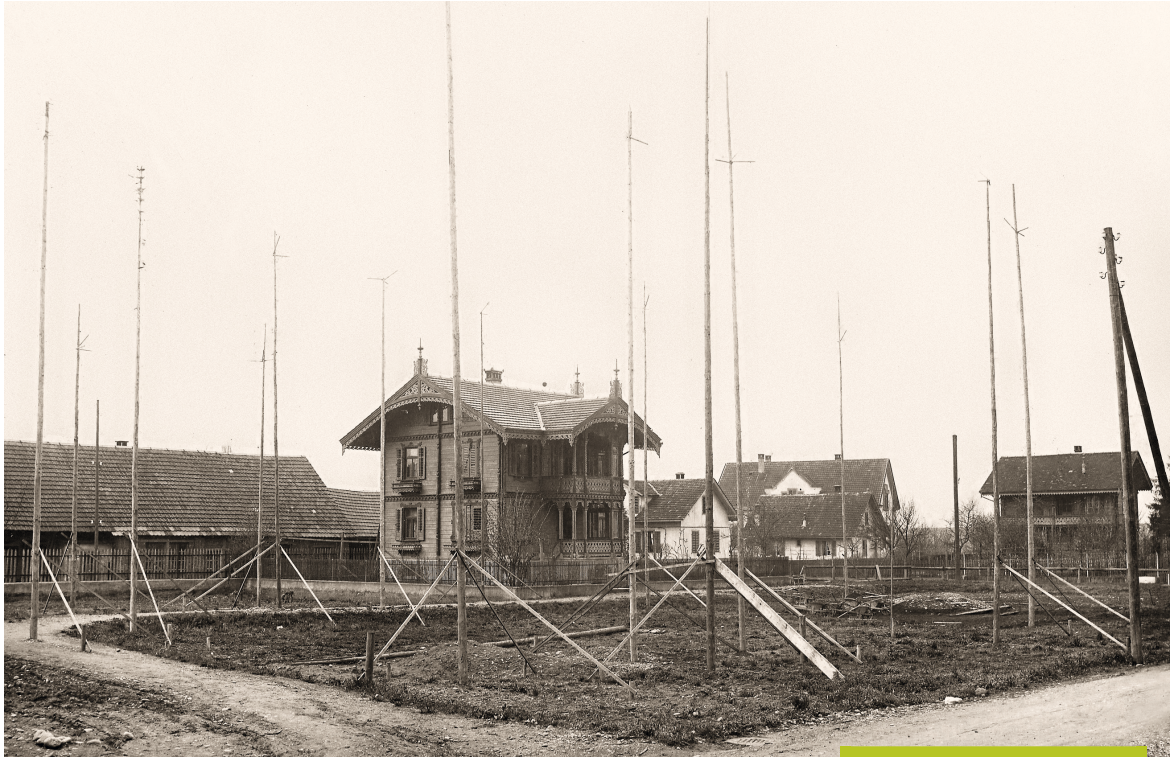
Ausgesteckter Bauplatz für die katholische Kirche Brugg. Im Hintergrund das damalige Pfarrhaus, heute Stapferstrasse 15.
