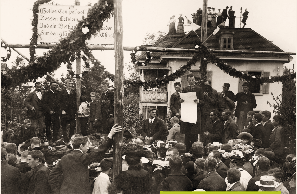
Viel Volk am Tag der Grundsteinlegung der Kirche St. Nikolaus am 21. Mai 1905: Der 29-jährige Pfarrer Albert Hausheer verliert die Urkunde, die eingeschlossen werden wird.
